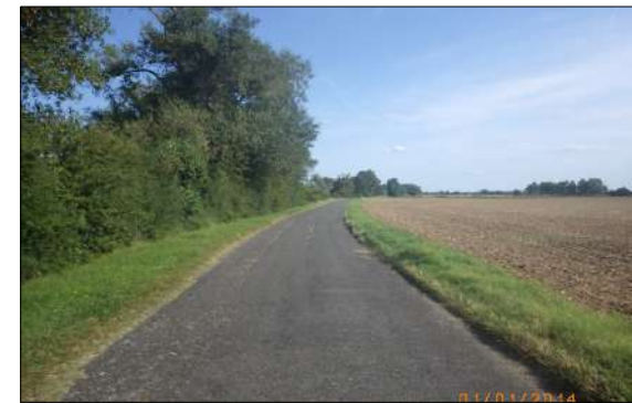
Déversoir au TN de la Martinaterie
